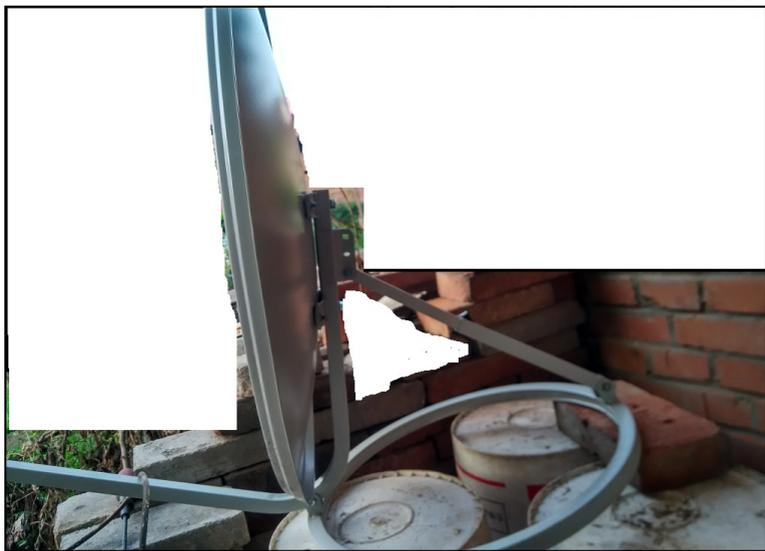
下图：“自制加长杆” 是用直径 16 毫米电工镀锌钢管制作的，26 厘米长，本地仰角 7-8 度，仰角更低的地区需要再长些。15×15 毫米方管或许更好，最好用镀锌材料，防锈好点。方管可能不如圆管好买，问
