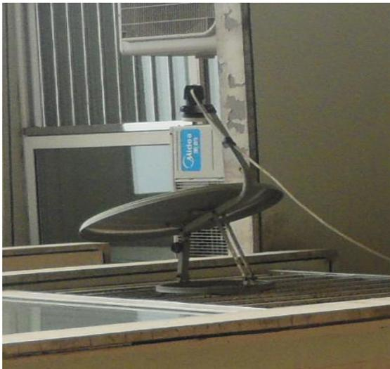
下图：“60 锅侧图” 是用的原装伸缩杆，短，后部垫砖才行。
