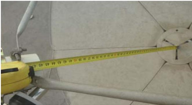
**4、主收中星6B--调仰角：**第一次接受中星6B调仰角，可以根据寻星计算机V1.0计算仰角，用量角器量好仰角后固定。使用方法请参看《卫星电视节目接收实用手册（图文版）》。一旦接收到信号后，第二次就不用使用量角器测量仰角了。更快捷简单的方法，就是用盒尺量一下已经接受成功的中星6B大锅背面用来固定仰角的滑动杆顶端到滑动套之间的距离，记下来。以后再接受中星6B的时候，量好这个距离固定，仰角就固定好了。
