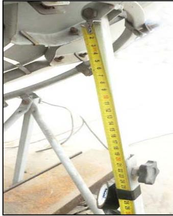
如果第一次接收中星 6 B，不方便用寻星计算机 V1.0 和量角器确定仰角的话，（比如说没有电脑，或者不会用电脑，而寻星软件是需要用电脑计算的。）可以在当地找一个已经接收成功了的和我們使用的同等大小的锅，量一下大锅背面用来固定仰角的滑动杆顶端到滑动套之间的距离，记下来，我们接收的时候，也按这个距离固定仰角，也是一样的。
